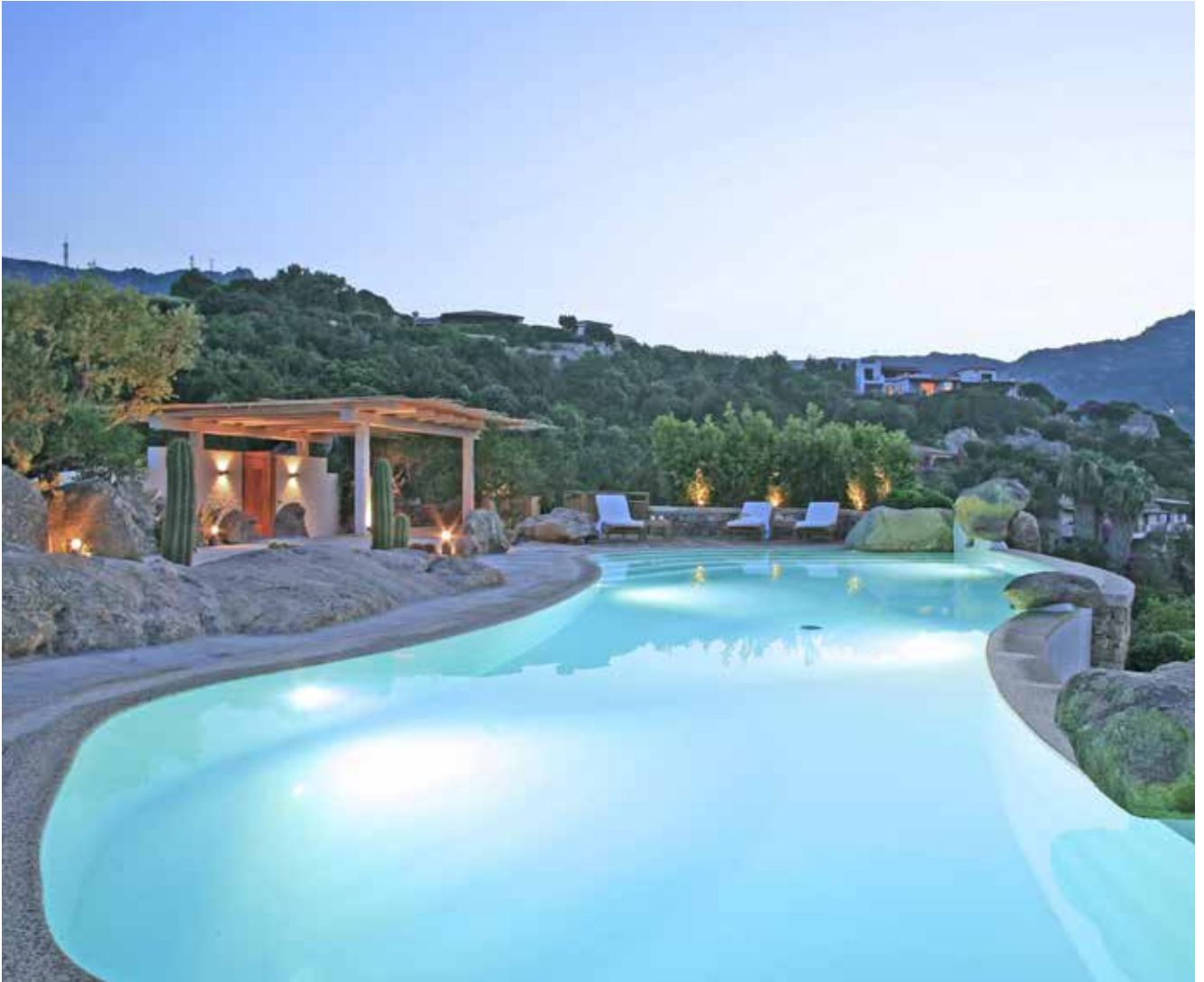
Vor allem auf individuelle Lösungen für eine anspruchsvolle Klientel hatte sich Jürgen Duhnke spezialisiert. Oben: Eine Poolanlage auf Sardinien, von der die Bauherrn den Blick aufs Meer haben. Unten: Ein Schwimmbad im vierten Stock eines Wohnhauses in Berlin und eine Schwimmhalle im venezianischen Stil.
